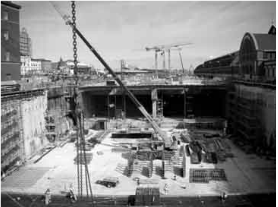
Anlægsarbejder ved Citytunnelen d. 7. september 2007. Foto: Peter V. Christensen
