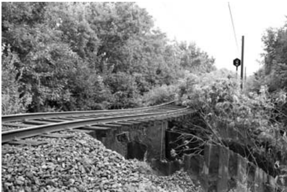
Det frithængende spor ved Adsbøl fotograferet d. 22. august 2007 af Jørgen Stibro Andersen.
